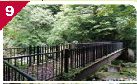
9 姉滝橋とさざれ石塊の大岩 いつも山霧と滝しぶきを浴びてツルツルだ。そして、袂の溶岩塊の大岩 苔生して存在感を放つ。
