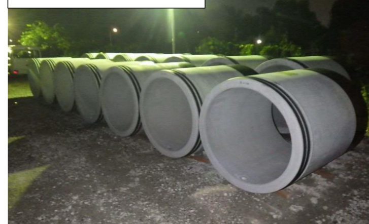
推進管 HP（直径1m）
