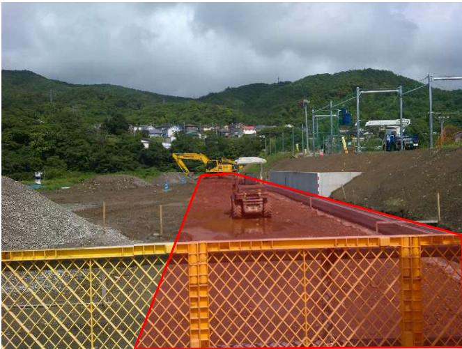
現在の道路新設工事状況
