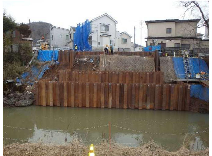
橋台（向田地区側）施工状況
