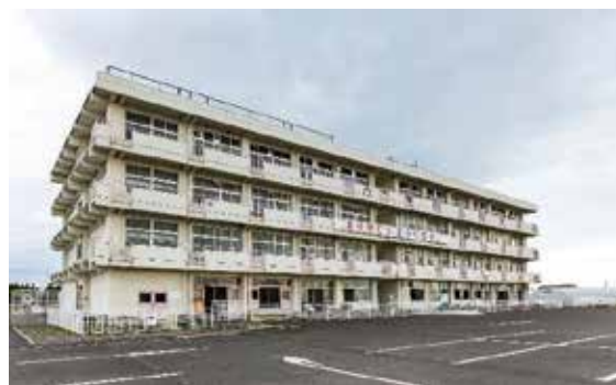
震災遺構仙台市立荒浜小学校
