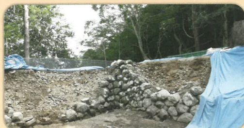
石垣解体の様子
