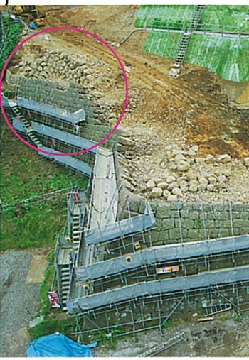
現存石垣と第二世代の石垣
