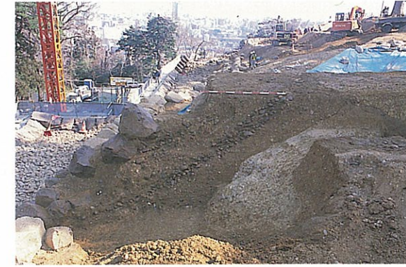
階段状石列と排水施設
