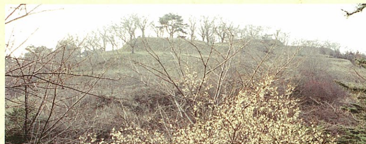
西部近景 平坦地が段状に重なっている
