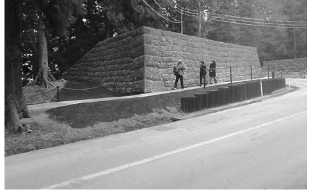
●復旧工事後の中門石垣（北西から）
