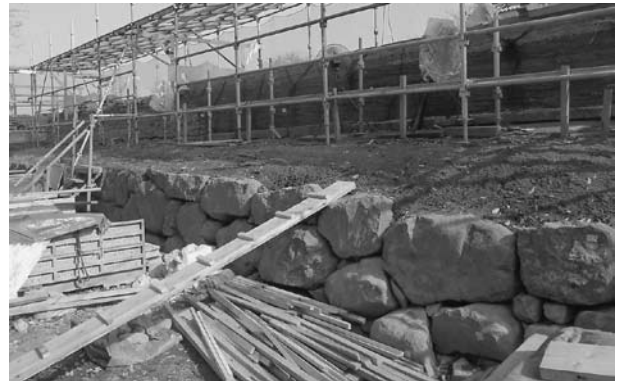
●復旧工事中の大手門北側土堀（北西から）
