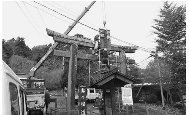
●亀岡八幡宮石鳥居の修理状況
