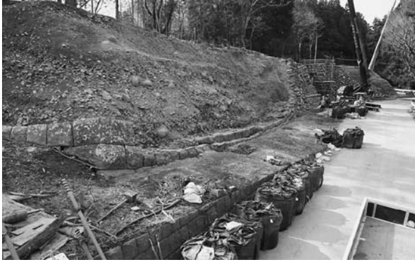
●本丸北西石垣の解体状況（北から）
