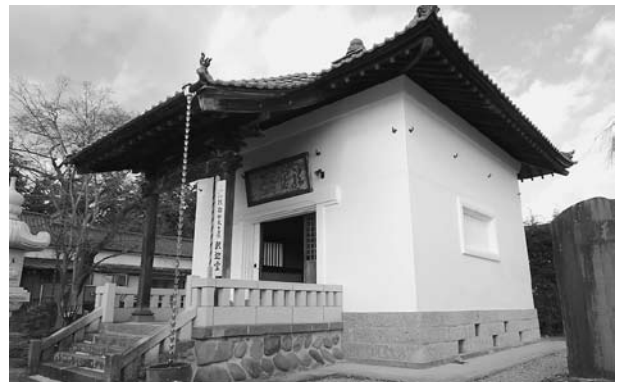
●釈迦堂の竣工状況
