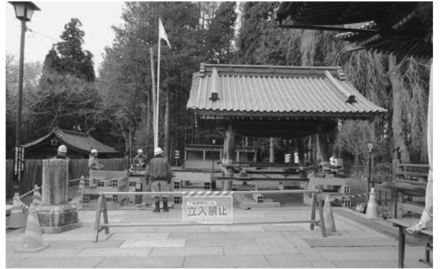
●東照宮の修理状況
