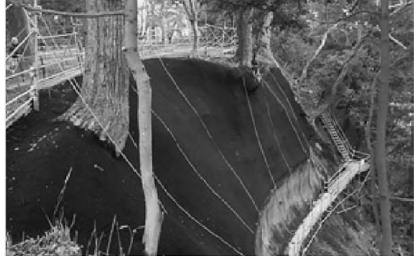
●崩落防止対策工事を終えた本丸東側崖面
