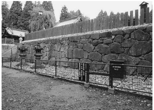
●東側石垣の竣工状況
