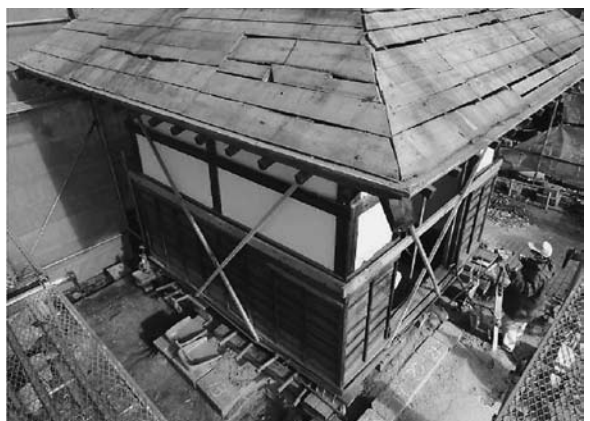
●善応寺開山堂の修理状況
