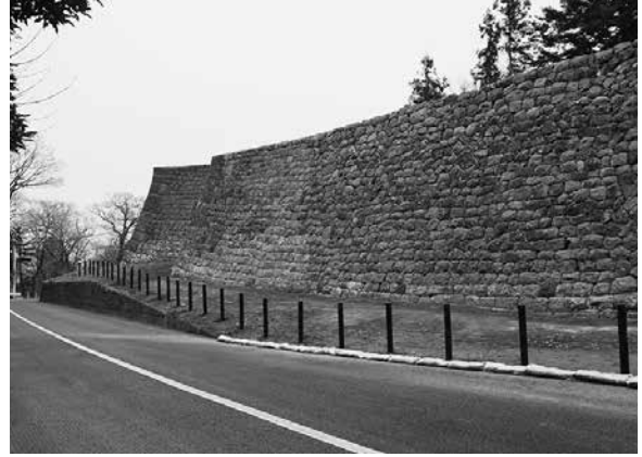
●積み直された本丸北西石垣北部（西から）
