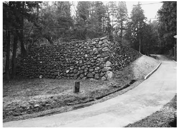
●復旧工事後の清水門石垣
