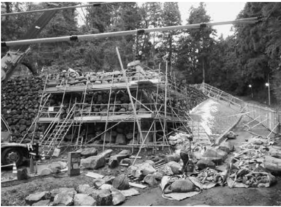
●清水門石垣の作業状況
