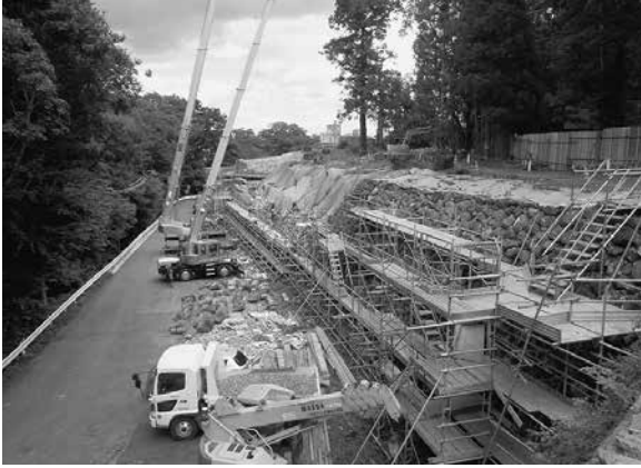
●本丸北西北部の作業状況
