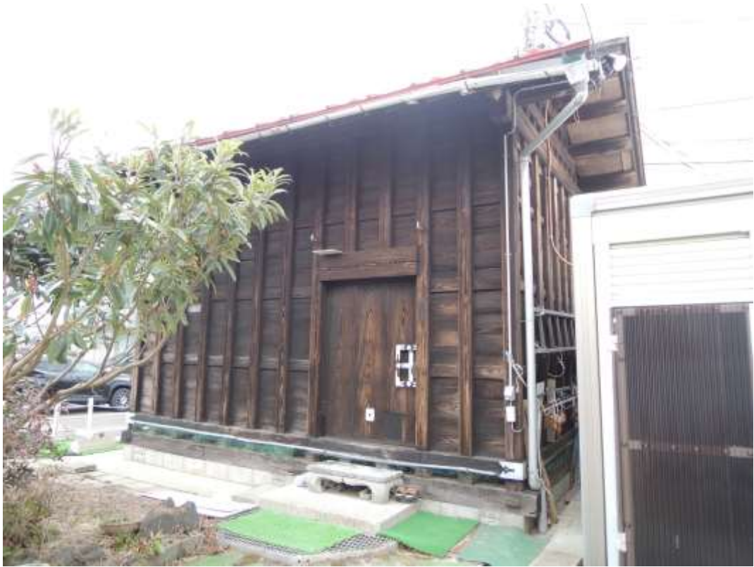
横田家住宅板倉（外観）
