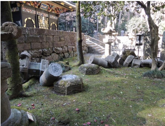
(市指定) 経ヶ峰伊達家墓所 善応殿前石灯籠倒壊
