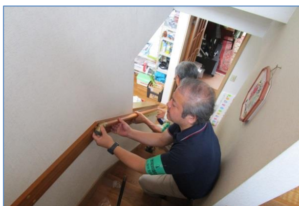
2人がかりで階段に手すりを取り付けています
