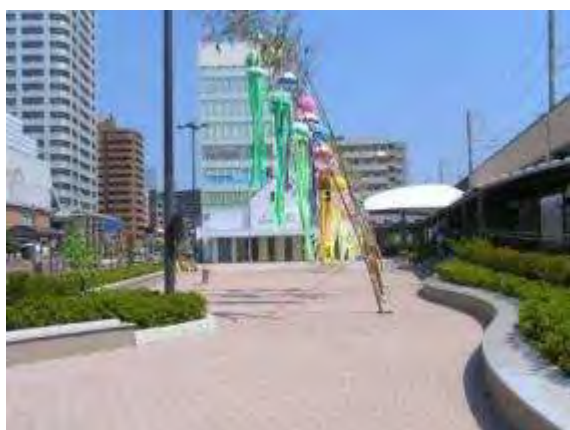
長町駅西口広場（あすと長町 HP より）
