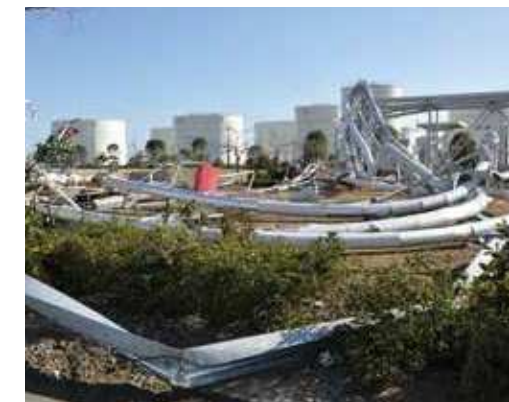
ガス局港工場 津波で壊滅的な被害を受けたガス局港工場
