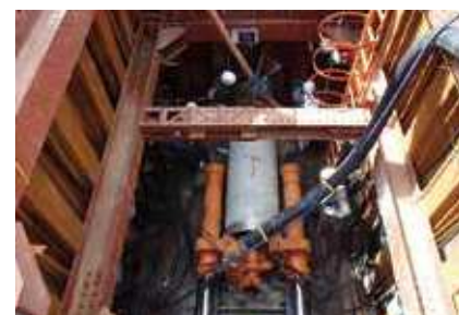
下水道推進立坑の掘削
