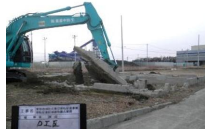
破砕機による碎石化
