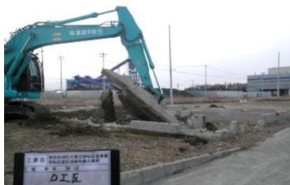
基礎撤去状況
