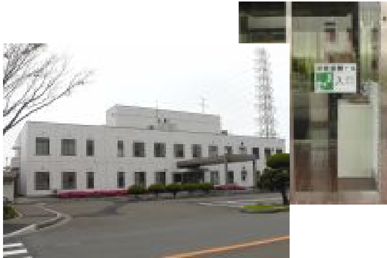
津波避難ビルの例 (麒麟ビール仙台工場)
