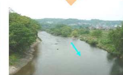
澱橋上流寄州 平成20年(2008年)6月
