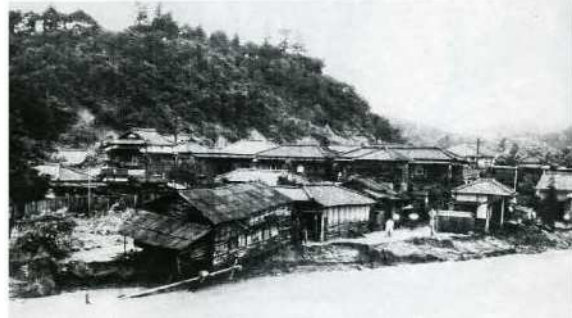
昭和25年8月洪水（広瀬川愛宕橋上流）
