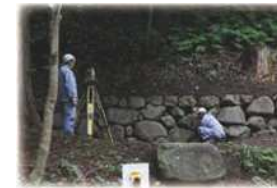
石垣測量の様子
