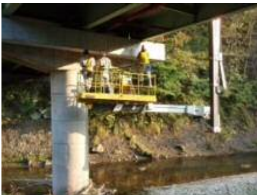
橋梁の点検状況
