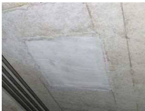
(天井部剥落箇所の断面修復)
