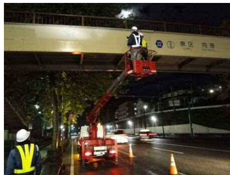
横断歩道橋点検状況（高所作業車点検：夜間交通規制）
