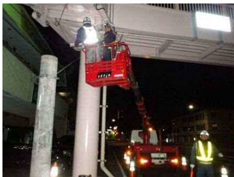
横断歩道橋点検状況（高所作業車点検：夜間交通規制）
