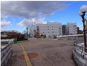
自転車・バイク駐車場デッキ1
