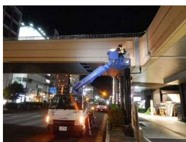
ペDESTリアンデッキの点検状況
