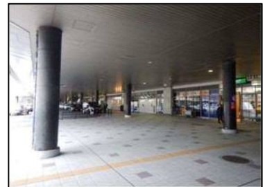
デッキ下状況（化粧パネル）
