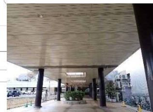
泉中央歩行者専用道路3号線デッキ1
