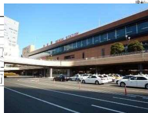
駅前広場デッキ2
