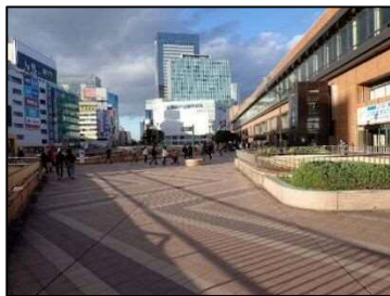
デッキ上歩道（タイル舗装）
