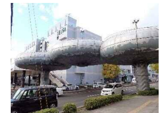
泉中央歩行者専用道路3号線デッキ2
