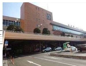
駅前広場デッキ3
