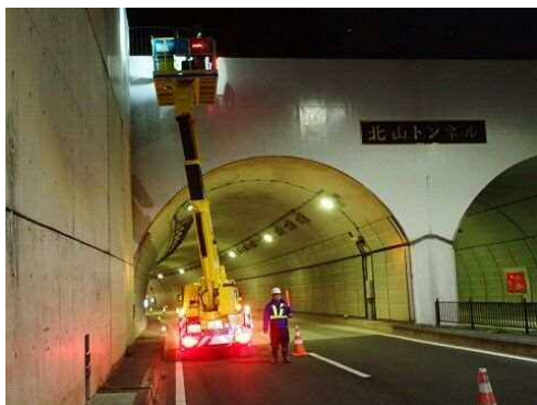
トンネル点検状況
