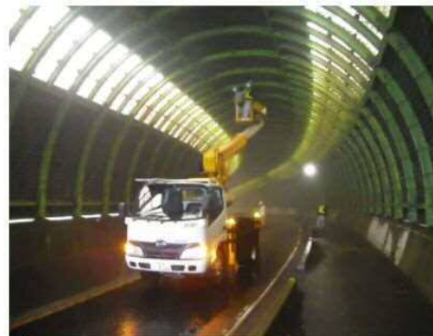
シェッド・シェルター点検状況
