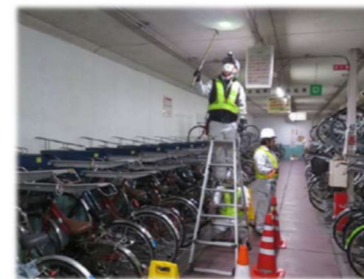
地下自転車駐車場点検状況
