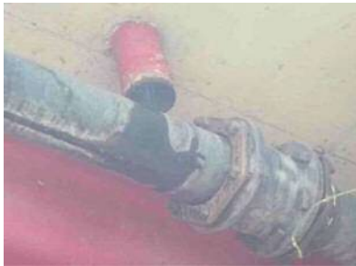
【損傷状況⑥】 腐食
