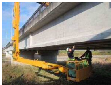
点検車による点検状況
