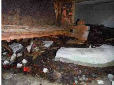
【損傷状況④】 沓座以外の欠損
