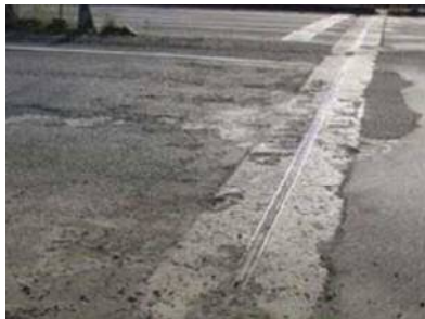
【損傷状況⑤】 後打ちコンクリートの欠損
