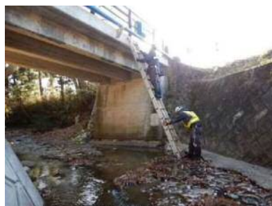
梯子による点検状況
