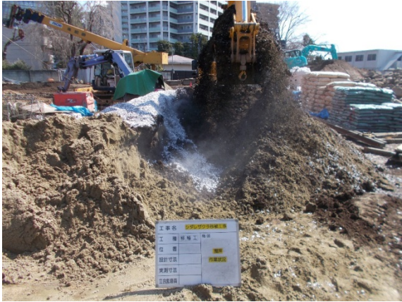
(土壤改良材攪拌状況)
