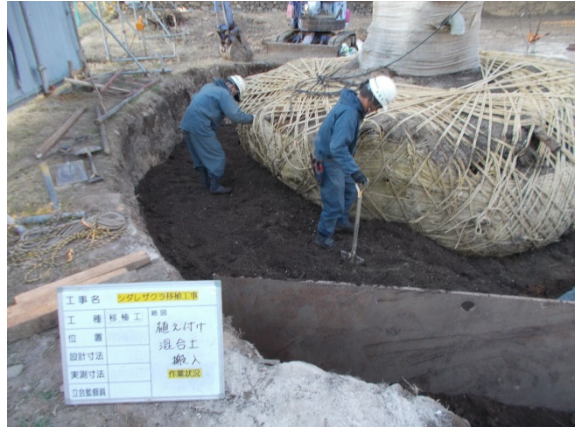
(混合土投入・植付状況)
