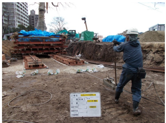
(コロ曳き作業状況)
