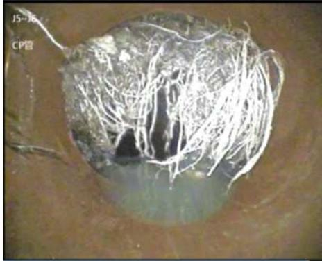
管の接続部から街路樹の根が侵入し、伸長することで排水不良（根詰まり）を引き起こしています。雨量が多いときには、路上への汚水溢水が発生する場合があります。
