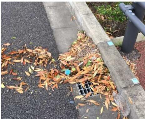
道路の排水溝等，排水施設への落葉により，台風等の大雨の際に排水施設が詰まり，道路が冠水する場合があります。
