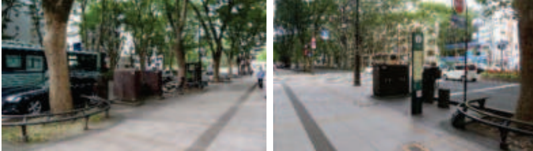
図 地上機器の設置状況
