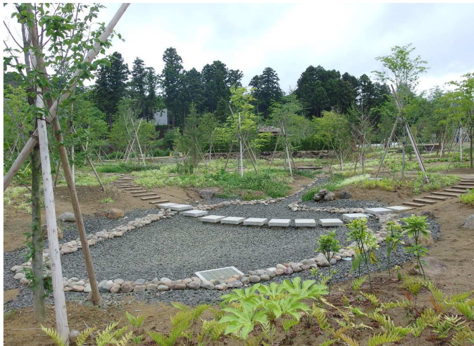
・青葉山公園追廻地区「もりの庭園」内の雨庭(池部)
