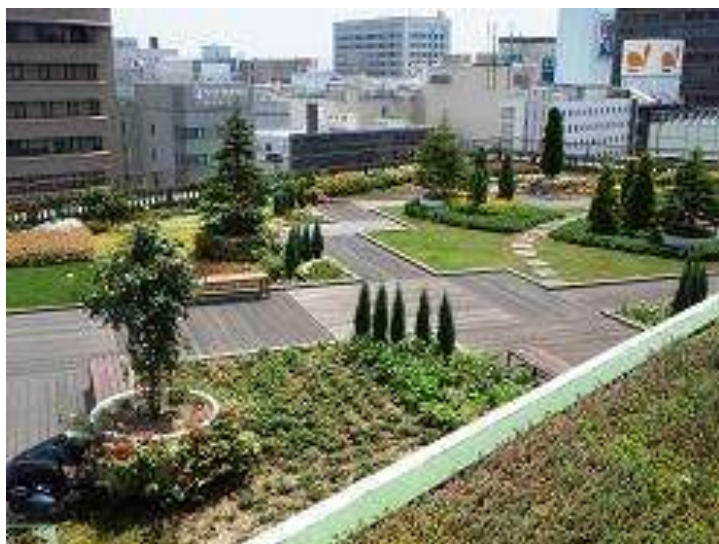
建築物緑化助成（電力ビル）
