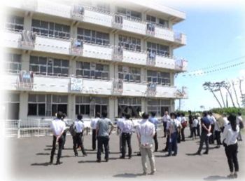
震災遺構仙台市立荒浜小学校
