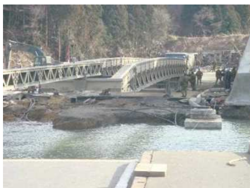
写真 応急仮設橋による通行確保
