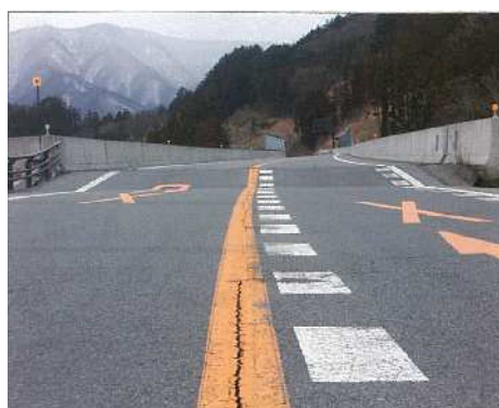
写真 応急復旧による通行確保
