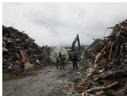
写真 警察・自衛隊・道路管理者の啓開調整状況
