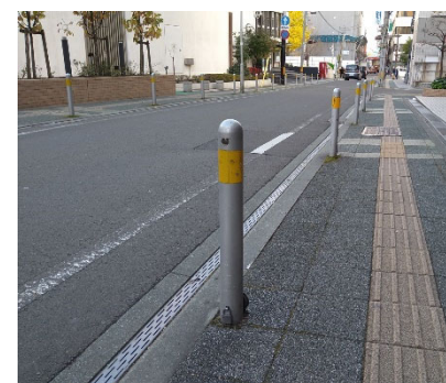
防護柵等の設置（ボラード）
