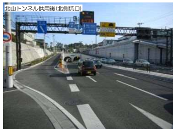
都市計画道路 北四番丁大衡線 北山工区・荒巻本沢工区
