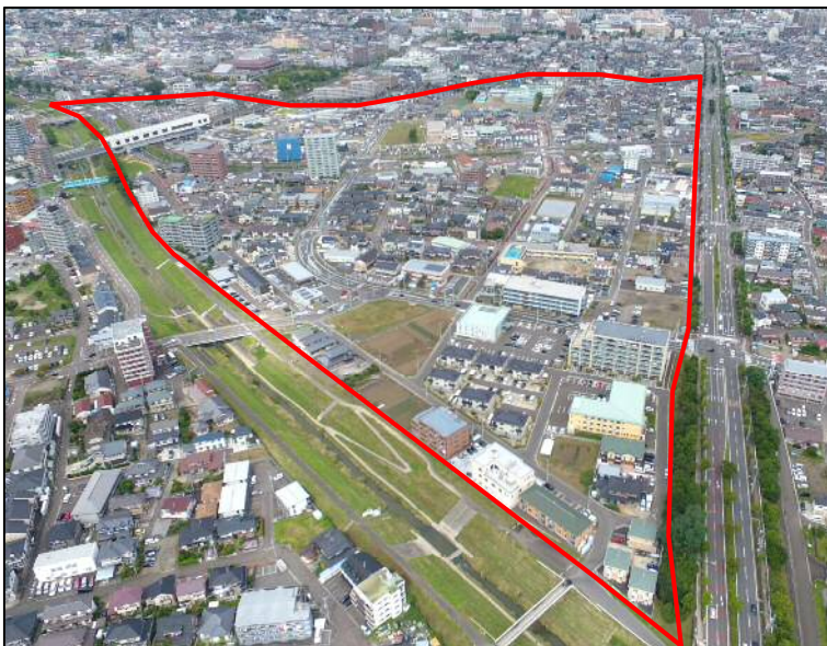
富沢駅周辺地区の全景（9月撮影）
