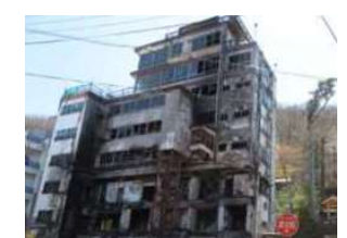
景観を損なう廃屋の撤去
