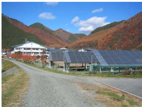
葛巻中学校太陽光発電施設
