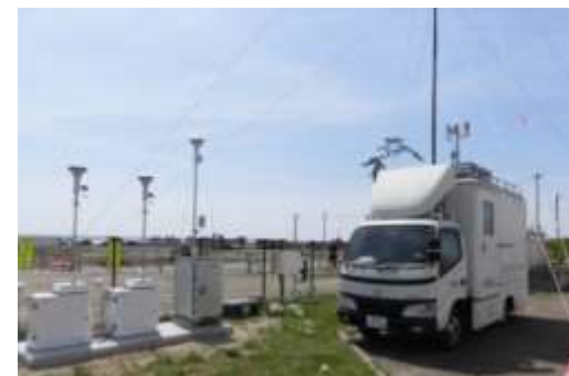
[移動測定車による大気調査]
