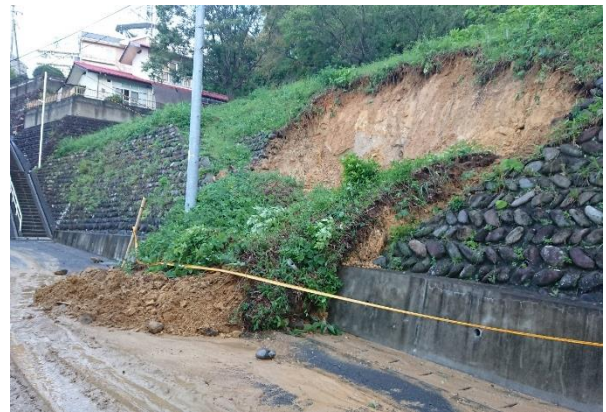
本市における土砂災害（がけ崩れ）の被害 （令和元年東日本台風）
