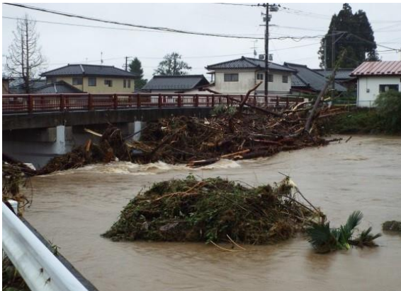
本市における洪水（河川氾濫）の被害 （平成27年9月関東・東北豪雨）
