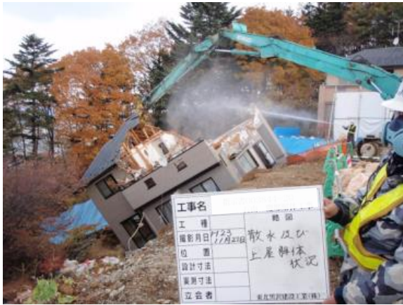
写真 1-8 損壊家屋等の解体・撤去状況
