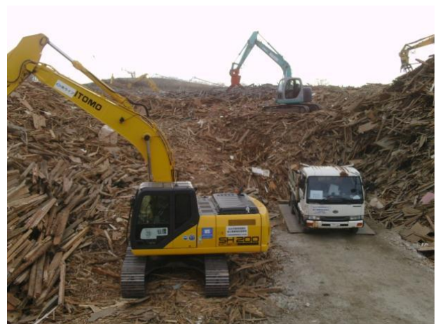
写真 1-5 搬入場内の分別保管状況（木くず）
