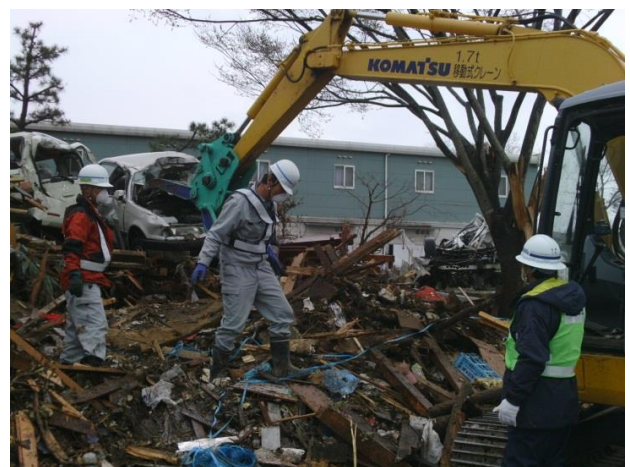
写真 1-7 宅地周りのがれき等撤去の状況
