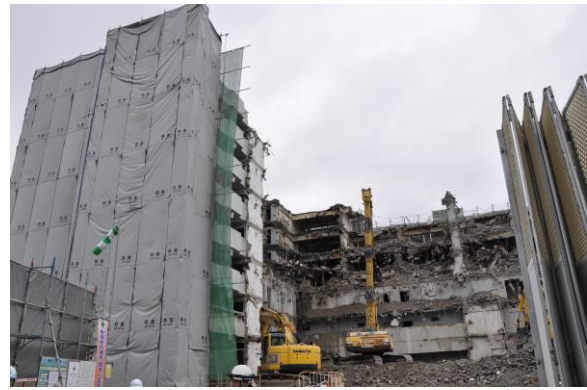
写真 1-9 大規模建築物の解体・撤去状況
