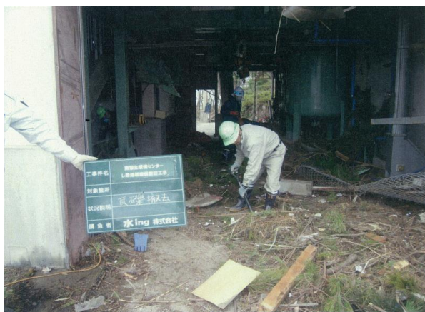
写真3-4-3 復旧作業の状況（ホッパ室）
