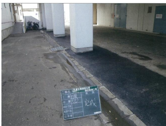
写真 3-3-3 舗装の復旧状況
