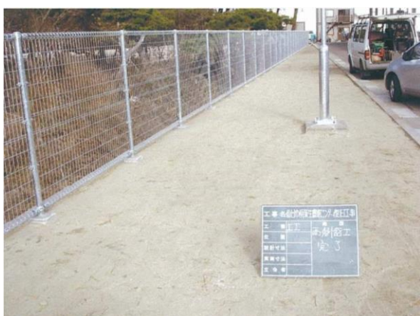
写真 3-4-7 囲障施設の復旧
