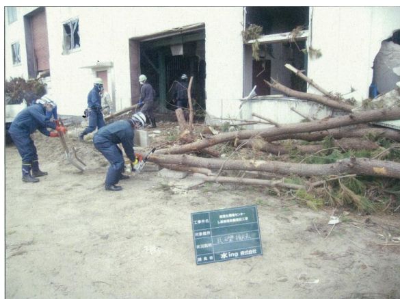
写真3-4-2 復旧作業の状況（がれき撤去）
