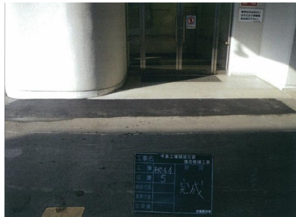
写真 3-3-2 建物周辺の地盤沈下復旧
