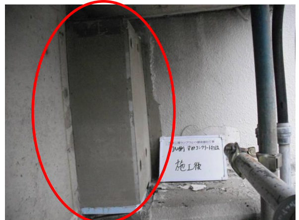
写真 3-3-4 ランプウェイの梁欠損及び鉄筋復旧状況
