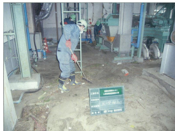
写真3-4-4 復旧作業の状況（焼却炉室）
