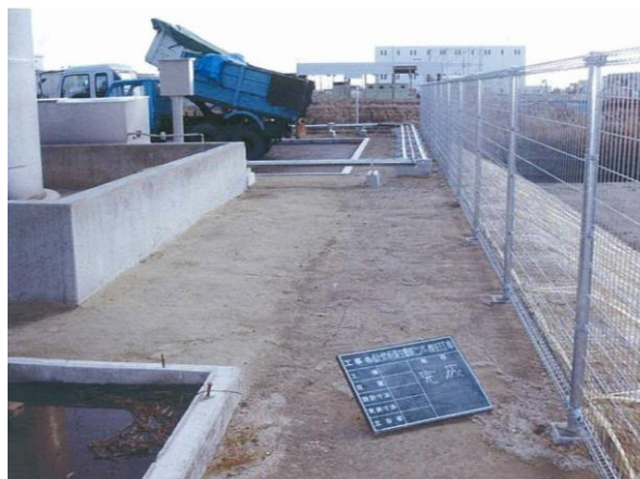
写真3-4-6 敷地盛土の復旧
