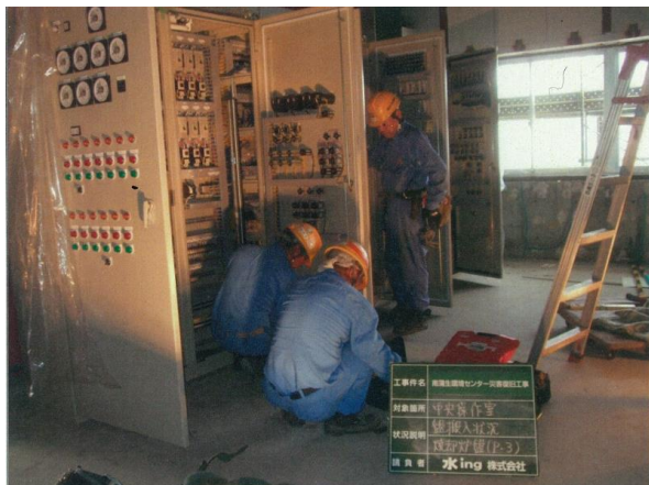
写真3-4-5 復旧作業の状況（中央制御室）
