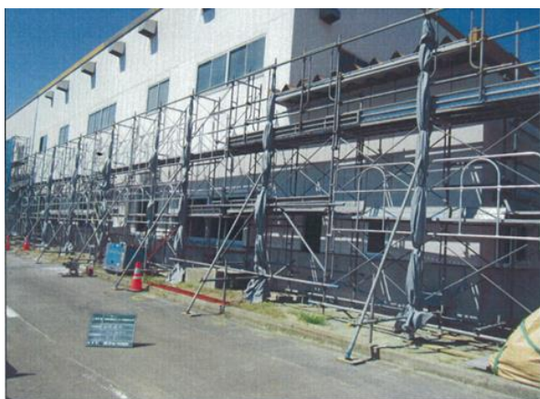
写真3-4-1 復旧作業の状況（東面ALC取付作業）
