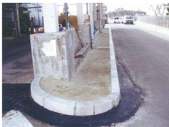
写真 3-4-8 排水構造物の復旧
