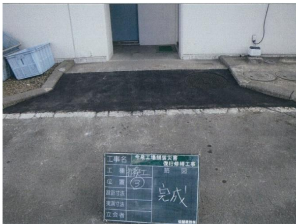
写真 3-3-1 建物周辺の地盤沈下復旧
