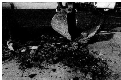
写真 8-1-6 基礎のみの解体
