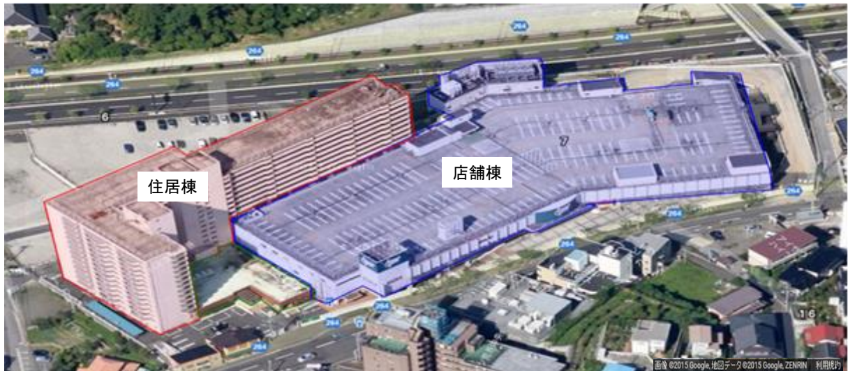
写真 8-1-7 大規模建築物の解体
