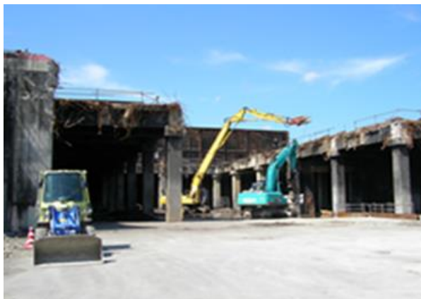
写真 8-1-3 SRC 造家屋の解体
