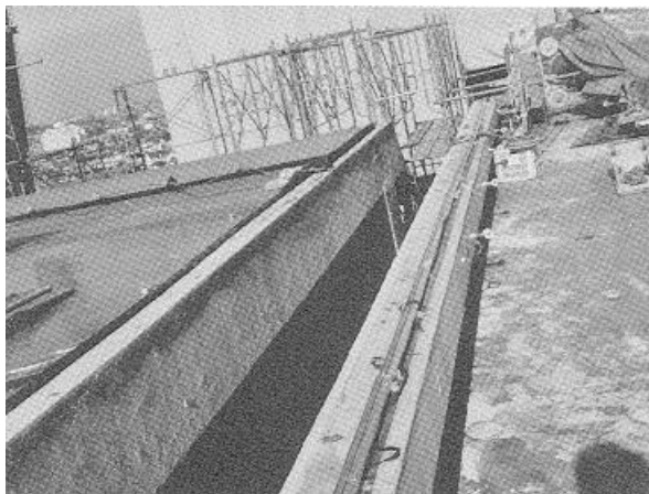
写真 8-1-9 1.1mの離れが生じた頂部
