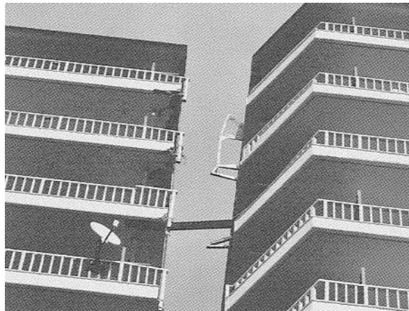
写真 8-1-10 鉄骨とワイヤーによる応急の倒壊 防止措置
