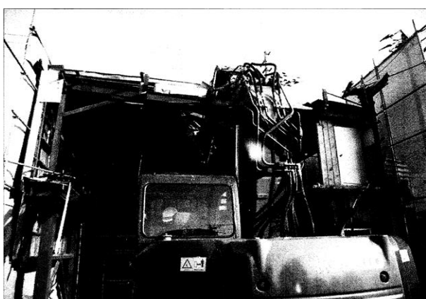
写真 8-1-5 S 造家屋の解体
