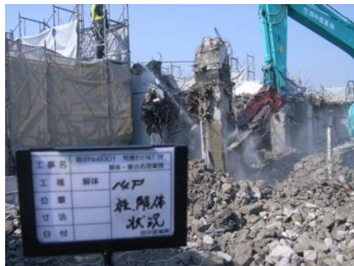
写真 8-1-8 大規模建築物の解体
