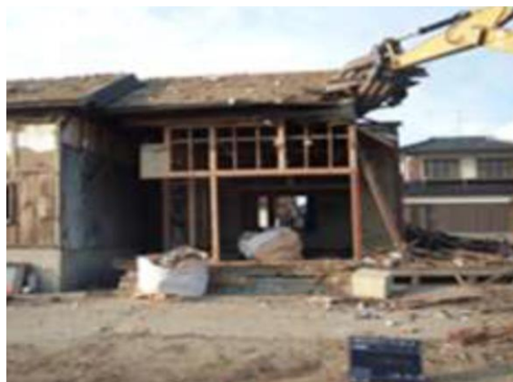
写真 8-1-2 木造家屋の解体
