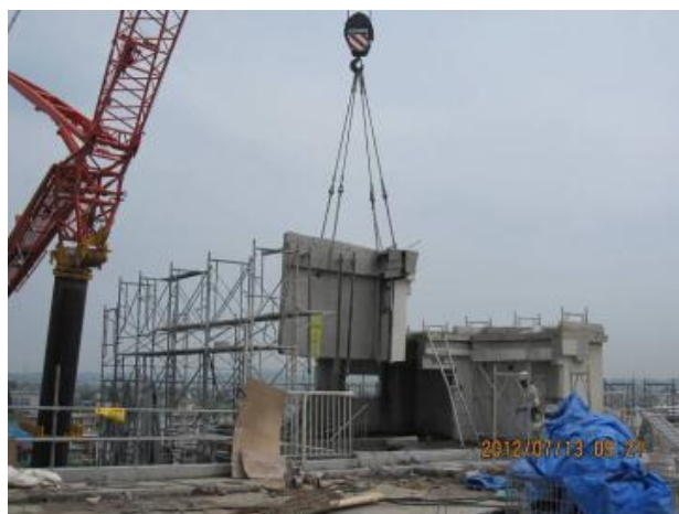
写真 8-1-11 200t 大型クレーンによる切断したブロックの吊り下ろし状況
