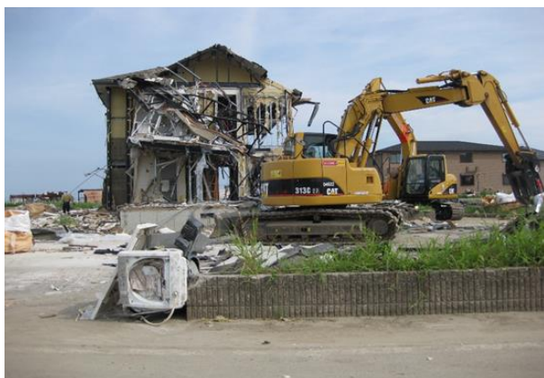
写真 8-1-1 津波被災家屋の解体
