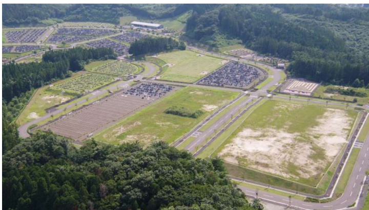
写真 5-2 第 2 期事業区域 2 工区の状況（令和 5 年 7 月 24 日撮影）
