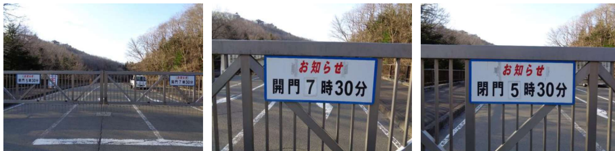
写真6-1 ピーク日の開園時間の延長の状況（令和6年3月16日撮影）
