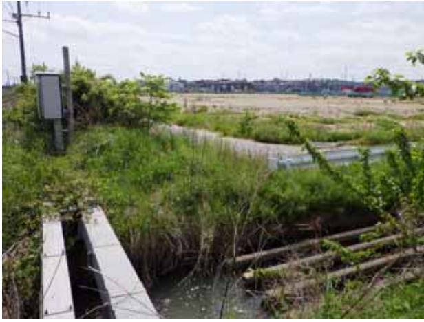
No.1 大井川踏切（西方向）
