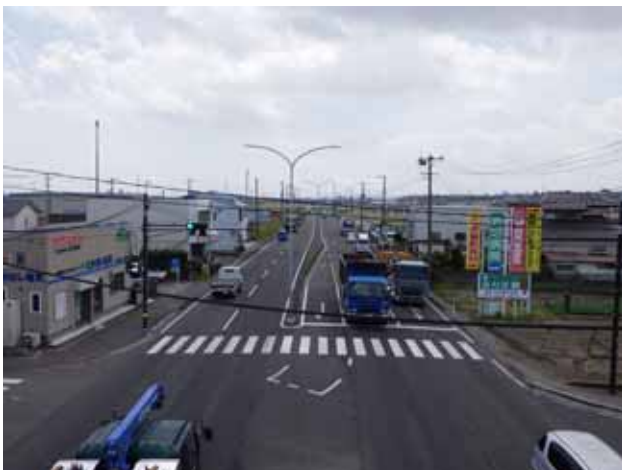
No.4 岩切歩道橋（南西方向）
