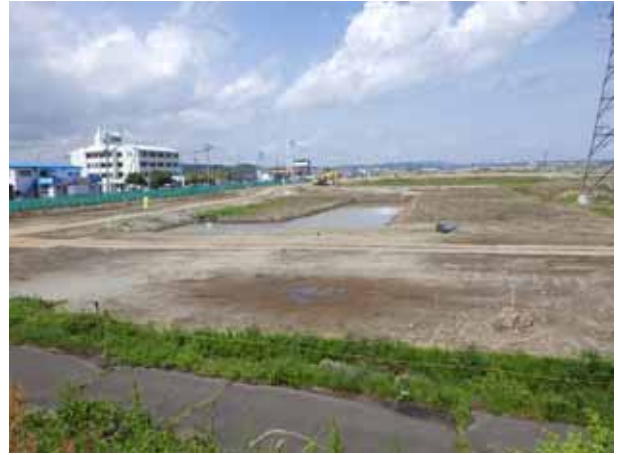
No.12 国道4号跨線橋（北西方向）
