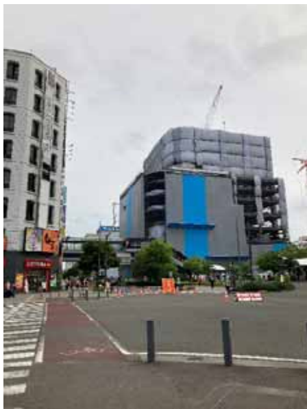
令和4年6月14日 地上階躯体建設
