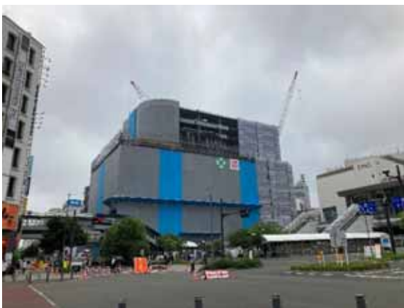
令和4年7月11日 地上階躯体建設
