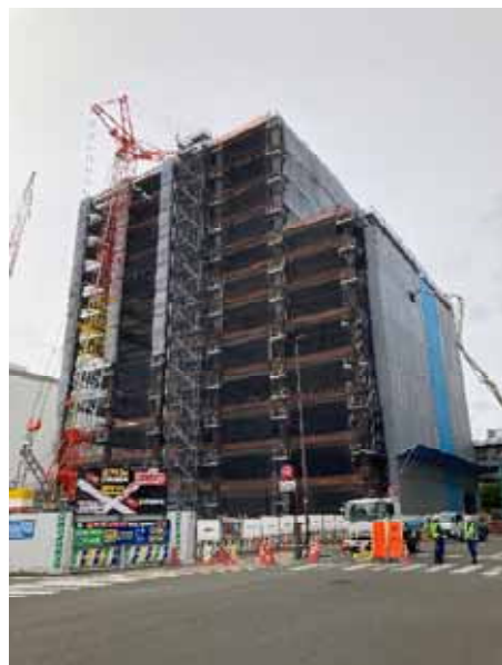
令和4年6月14日 地上階躯体建設
