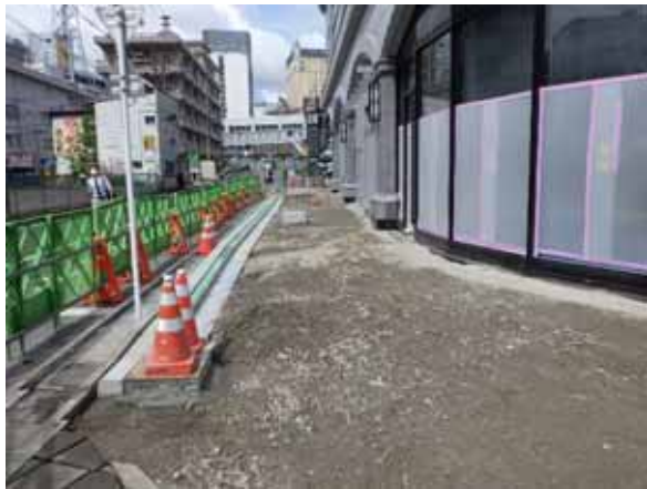
令和5年5月16日 建物南側外構工事
