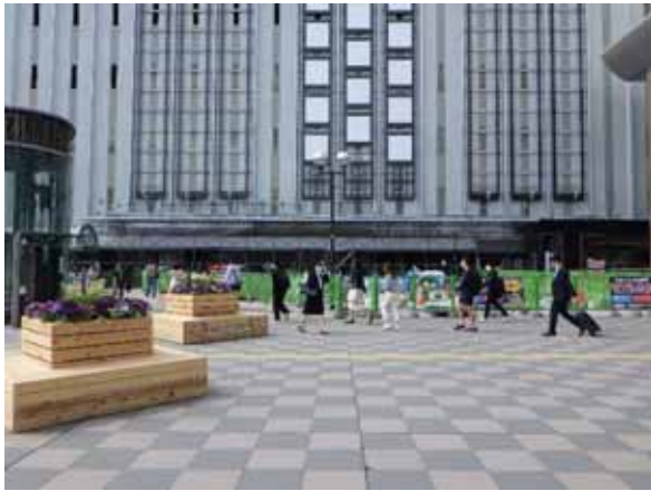
令和5年5月16日 ペDESTリアンデッキ上建設
