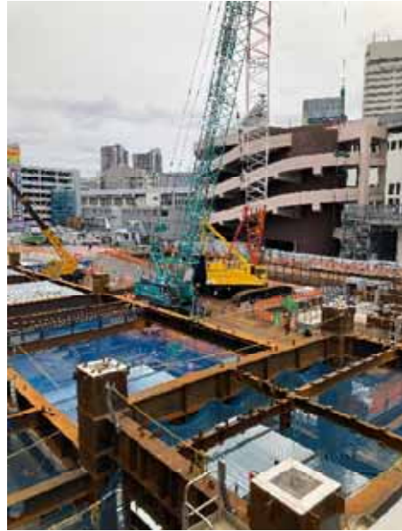
令和4年6月14日 地上階躯体建設
