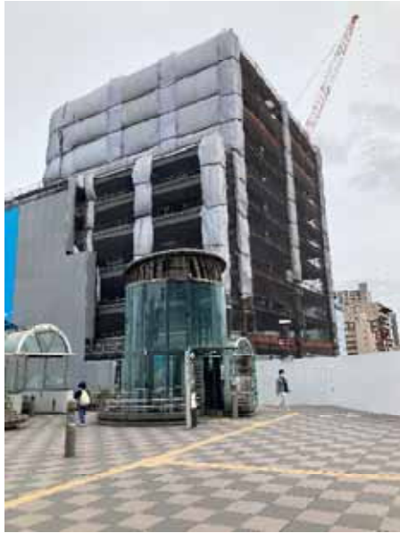
令和4年6月14日 地上階躯体建設
