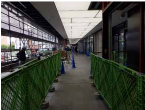
令和5年5月16日 連絡通路工事
