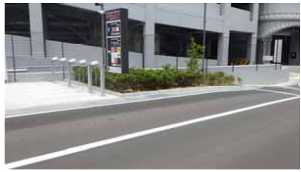
地上部緑化（立体駐車場南側）
