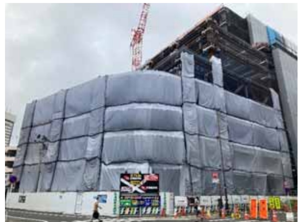
令和4年7月11日 地上階躯体建設
