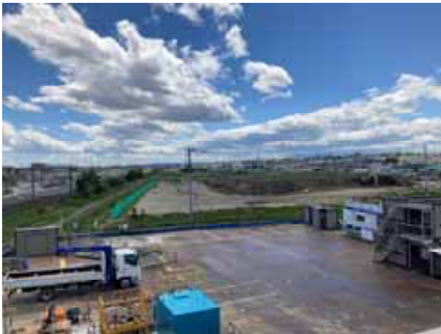
No.15 今市福田線跨線橋（南西方向）
