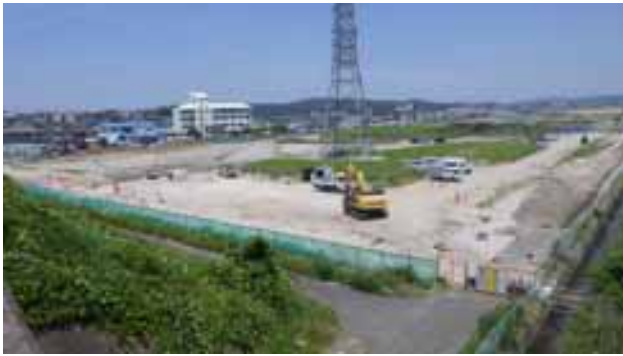
No.7 国道4号跨線橋（北方向）
