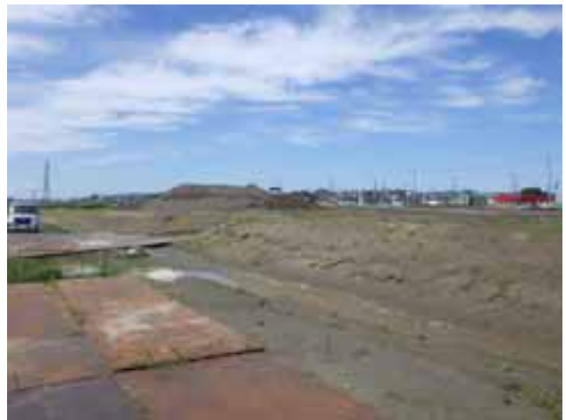
No.12 事業区域西側（西方向）
