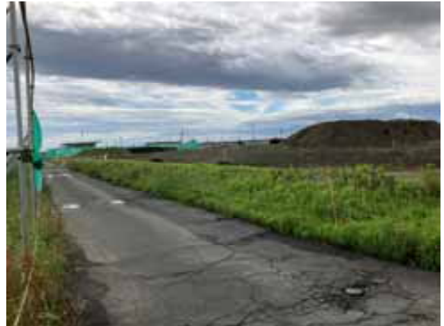
No.2 事業区域西側（南東方向）
