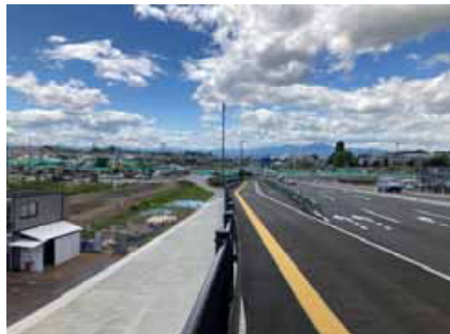
No.15 今市福田線跨線橋（北西方向）
