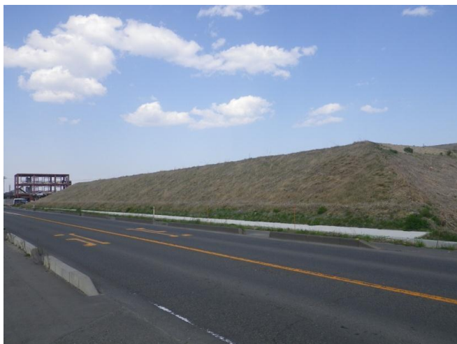
写真 3 緑化後の状況（平成 27 年 4 月 25 日）
