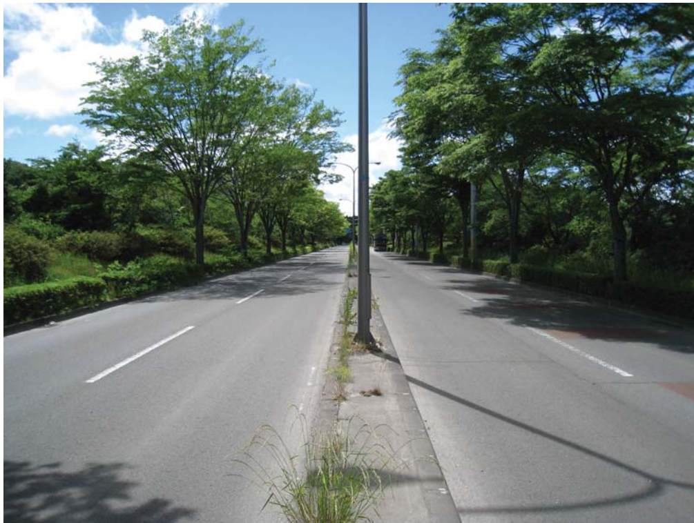
写真5 計画地北側隣接道路（西側を望む）
