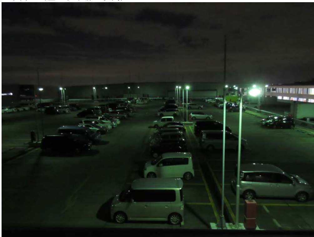
写真 11 事例 1 (屋上駐車場 夜間)
