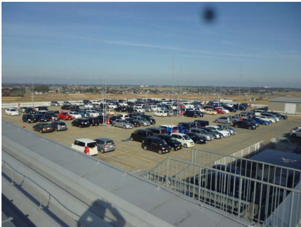
写真 16 事例 2 (屋上駐車場 昼間)
