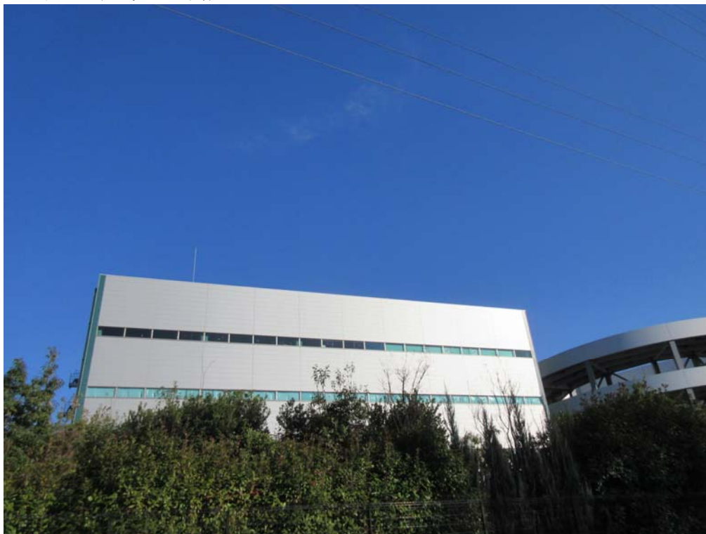
写真 14 事例 1 (外観 昼間)
