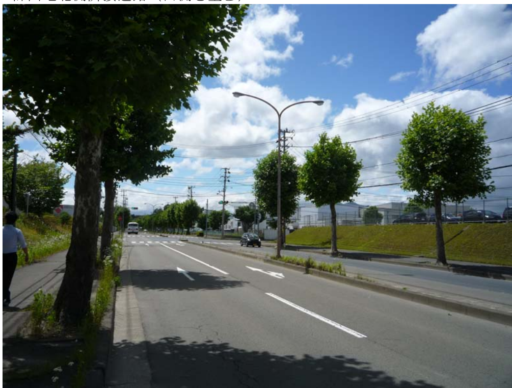
写真4 計画地北側隣接道路（西側を望む）
